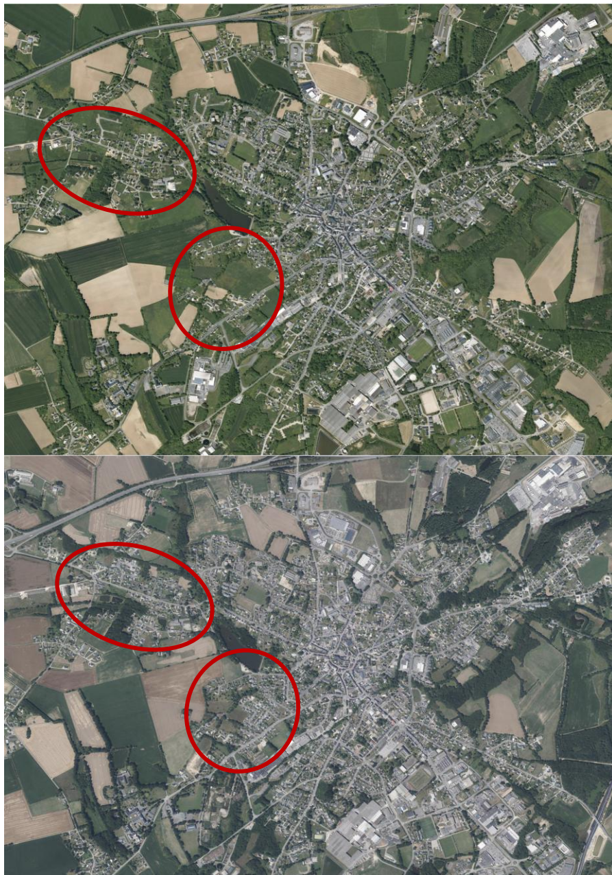
Exemples de densification et prolongement du tissu bâti d'un centre ville (secteur de Locminé), en 2006-2010 en haut et 2019 en bas (Source photographique : IGN).
